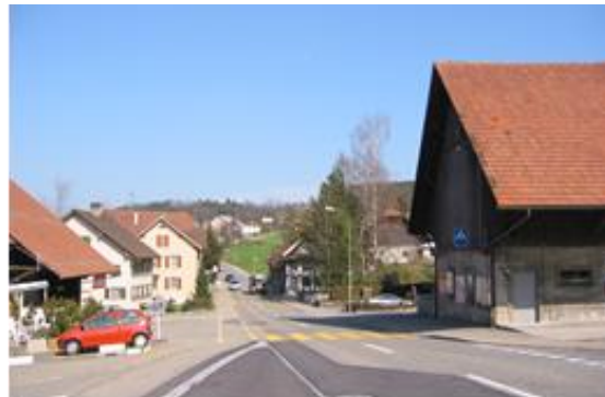
Raumbildende Wirkung der Bauten an der Zürcherstrasse
