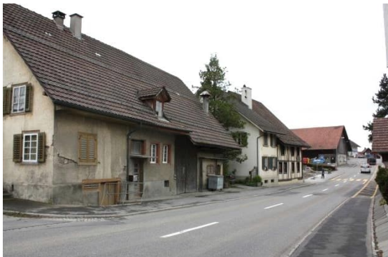
Gebäudezeile an der Zürcherstrasse K406
