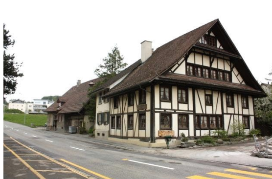
Gebäude mit Substanzschutz, Sennhüttenstrasse 1 / unübersichtliche Ein- und Ausfahrt
