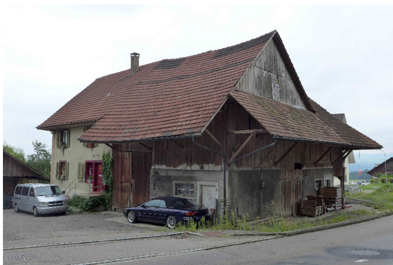
Ansicht von Nordosten (2019)
