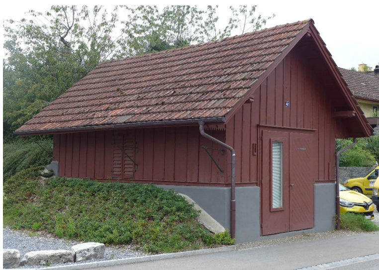
Spritzenhaus, Ansicht von Südosten (2019)
