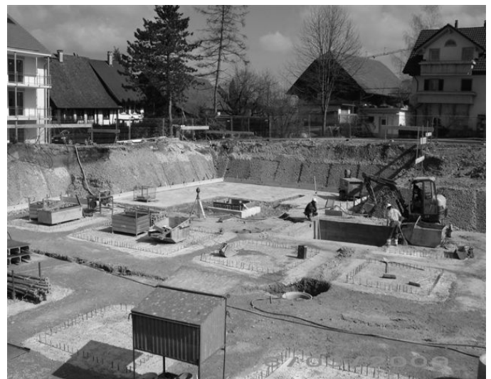
Grossbaustelle Arni - Lindenhof im März 2009
